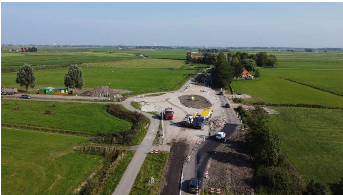
Aanleg nieuwe ovonde nabij Makkum.
